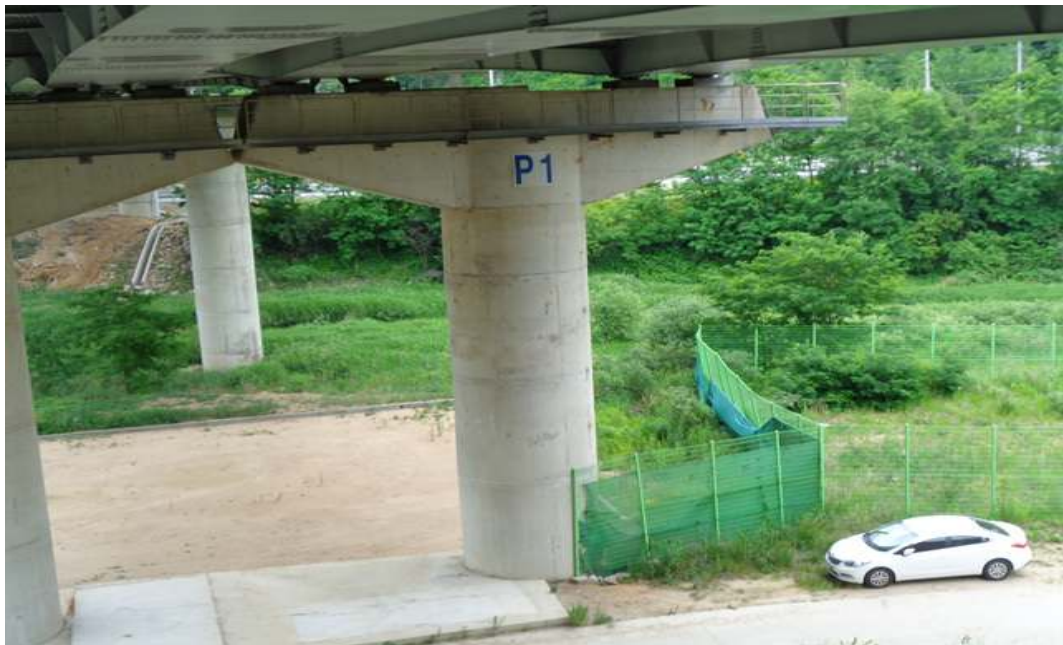
하 부 전 경(강릉)
